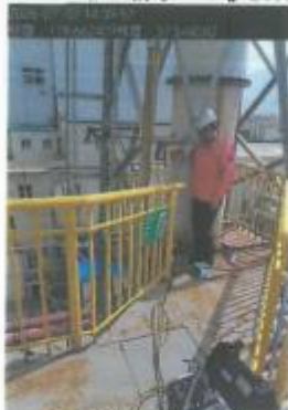
DA007 四车间排气筒
