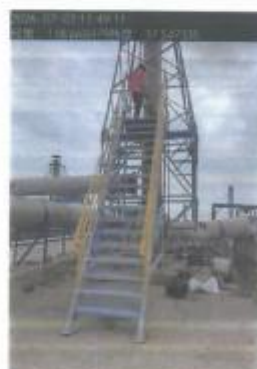
DA005 一车间烯胺尾气吸收排气筒
