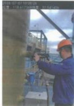
DA019焚烧炉排气筒
