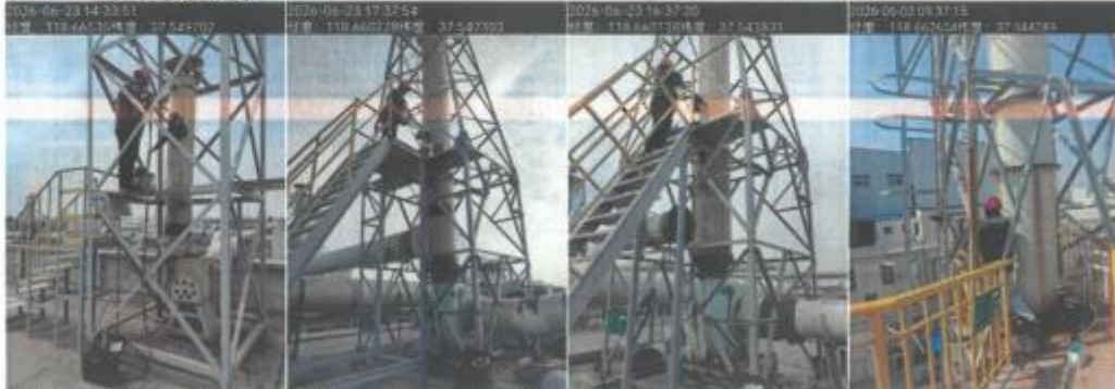
DA004 一车间销代尾气吸收排气筒 DA005 一车间烯胺尾气吸收排气筒 DA006 一车间噻啉尾气吸收排气筒 DA007 四车间排气筒
