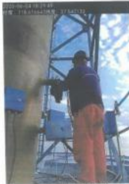
DA019焚烧炉排气筒
