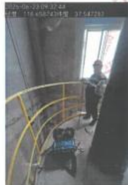
DA022 天然气焙盐炉排气筒
