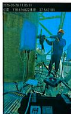
DA019 焚烧炉排气筒
