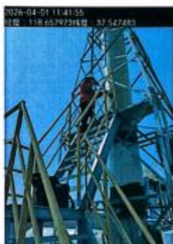
DA004 一车间钠代尾气吸收排气筒
