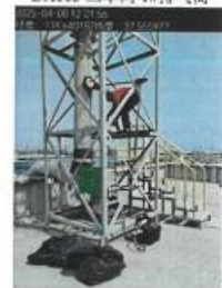
DA009 二车间排气筒
