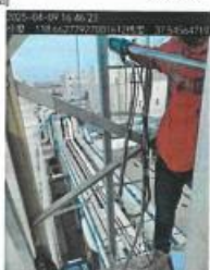
DA007 四车间排气筒
