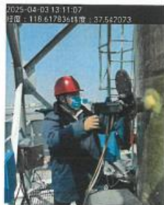
DA019焚烧炉排气筒
