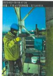
DA019焚烧炉排气筒
